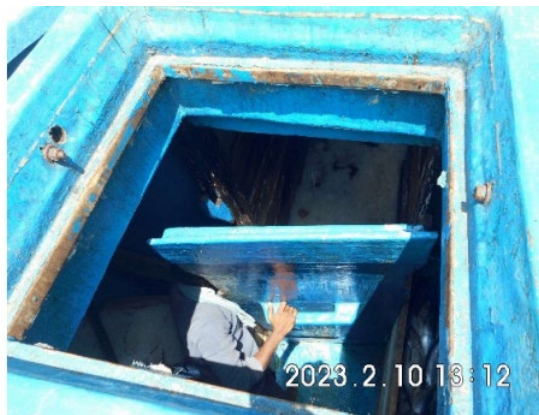
[Fig.30] Vérification du panneau interne entre les cales glacées
